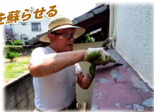
▲まず塗装を丁寧に剥いて綺麗な金属面に新しく塗り直す
